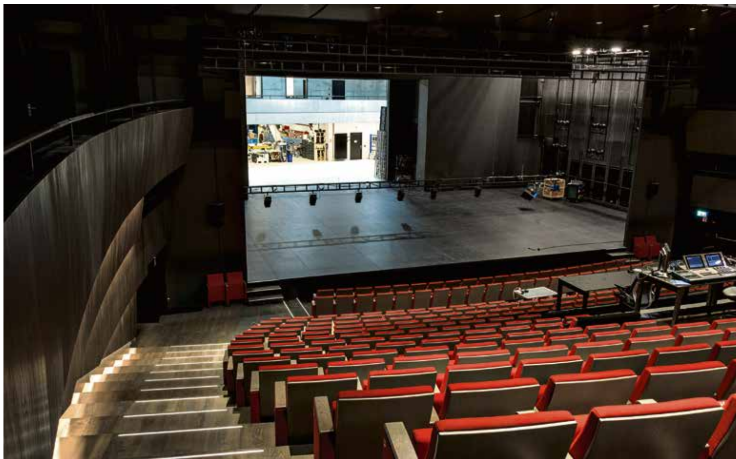
La grande salle avec ses 468 places, sa cage de scène haute de 20 mètres, ses 58 perches et son cadre de scène de 14 mètres d'ouverture. Mais le grand atout du Théâtre de Carouge, c'est que les ateliers de construction se situent au même niveau que le plateau, comme on le voit ici. (Eddy Mottaz/Le Temps)
