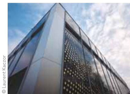
Un détail de la façade.
